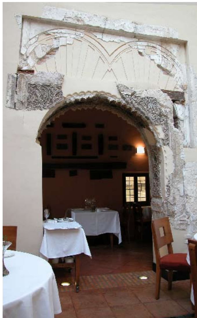
Figura 9. Calle de la Soledad nº2: “ casa del Temple” arcos islamicos geminados y un arco mudéjar de medio punto superpuestos.
