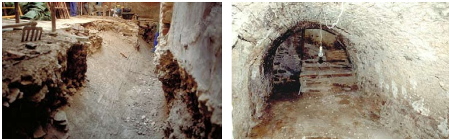
Figura 6. Calle Martin Gamero, s/n Sótano de una sola nave que ocupa toda la parcela en hilera, A. Extradós, B. Intradós
