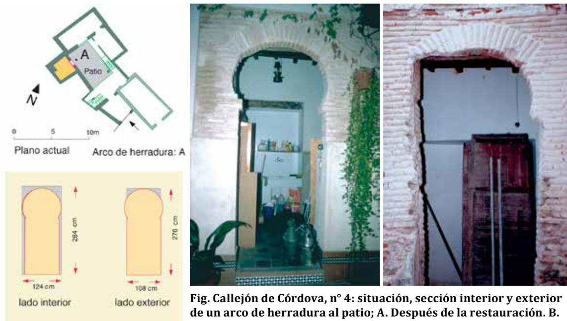
Fig. Callejón de Córdoba, nº 4: situación, sección interior y exterior de un arco de herradura al patio; A. Después de la restauración. B. Antes de la restauración
