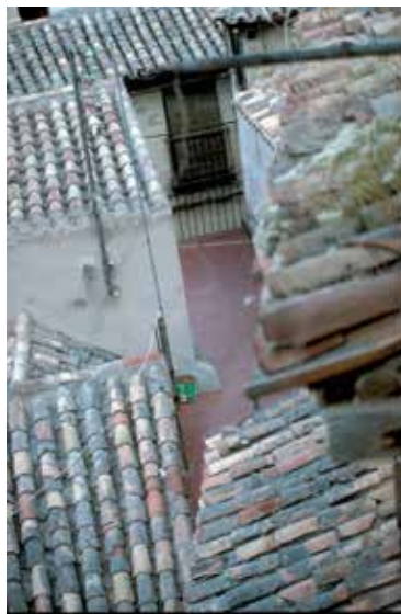
Calle del Pozo Amargo, n° 4: D-21: “calle corral con su latrina”
