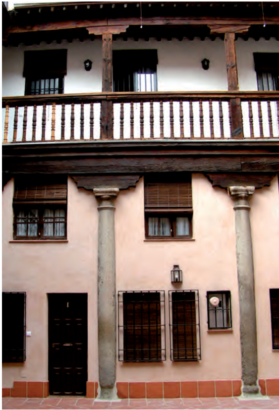
Figura 2. Patio del inmueble situado en la plaza de Amador de los Ríos, 2
