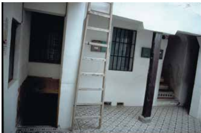
Cobertizo del Pozo Amargo, n° 4: patio
