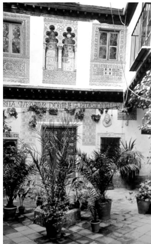
Fig.4. Callejón del Vicario, nº 4 (casa demolida en la segunda mitad del siglo XX): patio interior neo-mudejar
