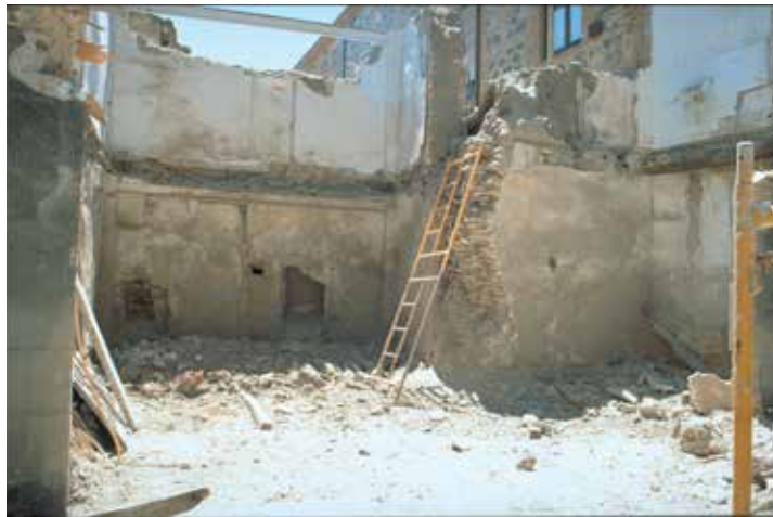
Calle Cardenal Cisneros, n° 2: a la derecha, restos del muro maestro de la antigua casa del Deán (Palacio de Justicia), 1997.
