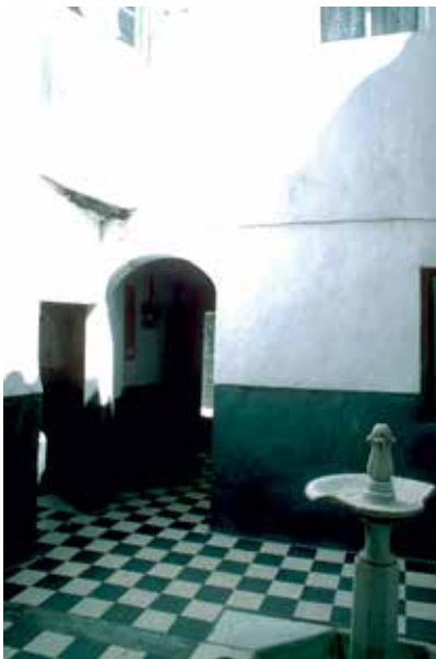
Calle del Pozo Amargo, nº 2: Patio y entrada secundaria
