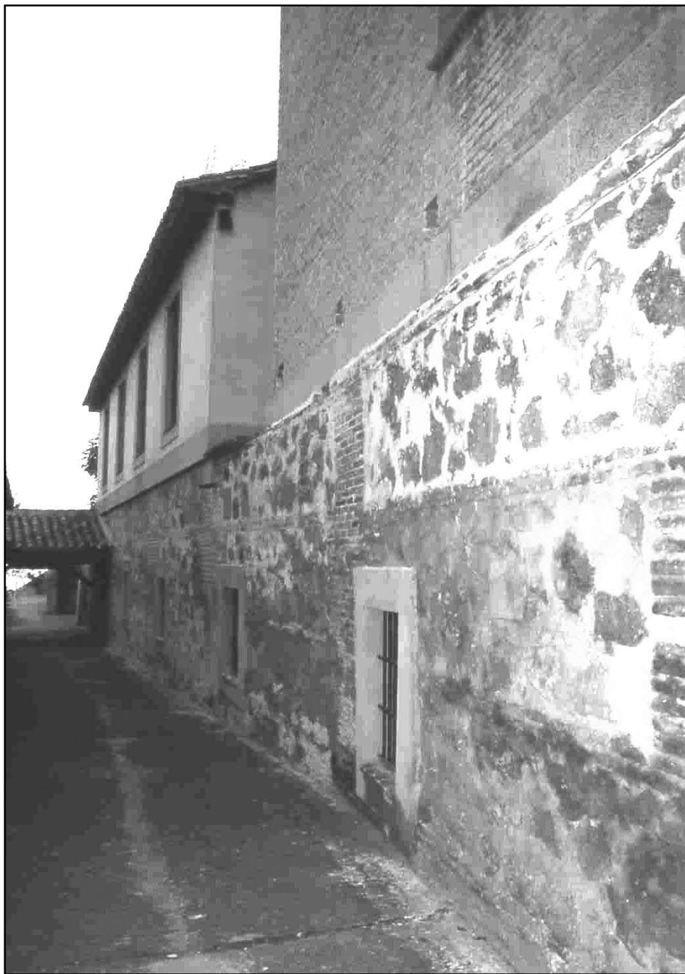
Figura 2.- La calle del Mármol, hoy privatizada, hacia la iglesia de San Juan de los Reyes y el cobertizo. A la derecha, se nota la planta baja de un cuerpo del segundo claustro (hoy desaparecido).
