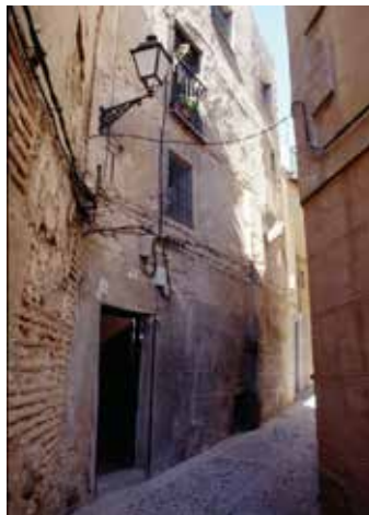
Callejón de Esquivias nº1: fachada.
