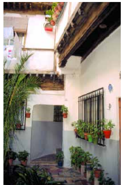
Plaza del Colegio de Infantes, n° 4. Patio; la galería se apoya sobre una viga.
