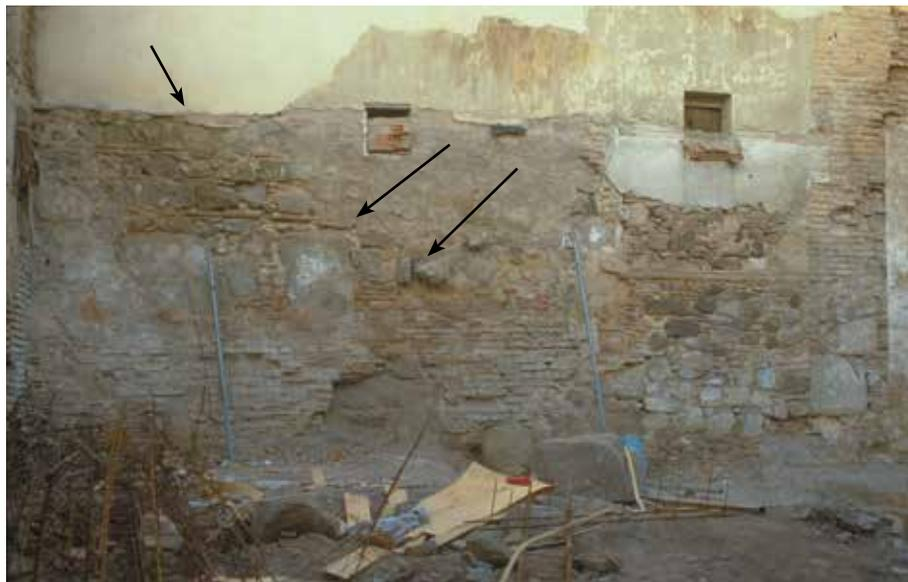
Plaza del Seco, n° 5. Exterior del lado suroeste de los dos palacios. A nivel del sótano se observa un aparejo de tipo islámico.
