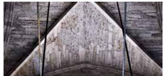
Figura 10. Desórdenes constructivos. Diferencia en el tratamiento de los paramentos exteriores: A. Tramo 7, nave oeste. B. Tramo 19, nave este. C. Tramo 22, plemento de bóvedas relleno de ladrillo (daños observados en los tramos de la nave este antes de su restauración).
