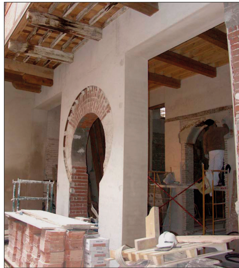
Fig. 16. Bajada del Pozo Amargo n.º 2. Arco califal y arco mudéjar en una casa cerca de la catedral.
