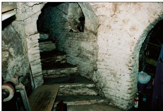
Fig. 20. Bajada del Pozo Amargo n.º 3. Propuesta de identificación del espacio como la sala de abluciones de la mezquita de barrio identificada por la existencia de agua en las proximidades, la presencia de una rampa con escalera y un nicho.
