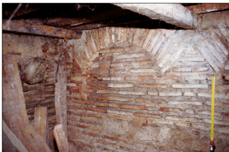
Fig. 5. Calle Estantales n.º 1, restos de edificaciones enterradas durante el siglo XIII, cuando se edificó el ábside mayor de la catedral.
