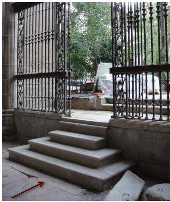
Fig. 8. Acceso al jardín que sustituyó la escalera doble que protegía el brocal islámico. (En el ángulo inferior izquierdo se aprecia una tapa del aljibe).
