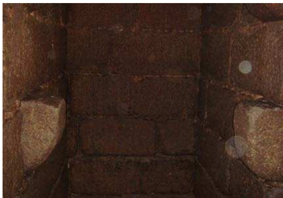
Fig. 22. Interior del pozo gótico. Detalle de las ménsulas.
